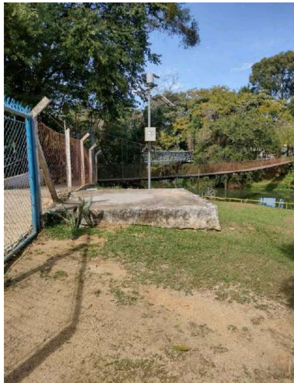
Estação Telemétrica Limpa (longe)
