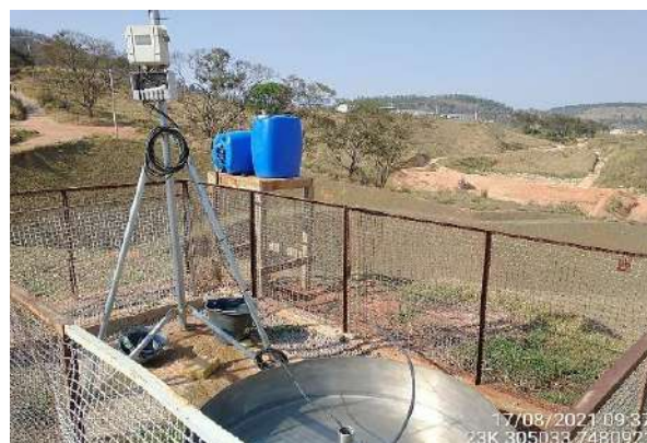
Foto 6 – Tanque do reservatório preenchido com água limpa. (Data: 17/08/2021).
