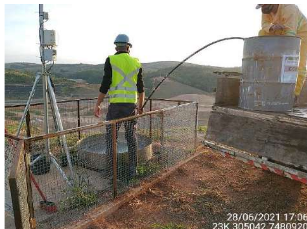
Foto 2 – Tanque do reservatório sendo preenchido com água. (Data: 28/06/2021).
